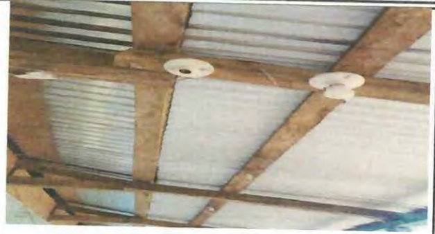
Foto2: SUSTITUCION DE COSTANERAS POR DE METAL
