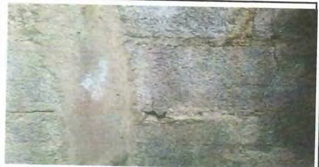
Foto 4: REPELLO Y CERNIDO EN LAS PAREDES Y APLICACIÓN DE PINTURA
