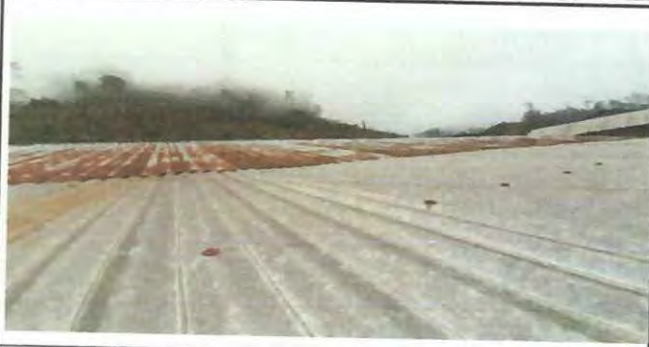
Foto 1: SUSTITUCION DE LAMINAS
