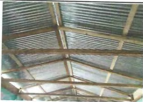
Foto 3: SUSTITUCION DE ESTRUCTURA METALICA Y CUBIERTA DE LAMINA
